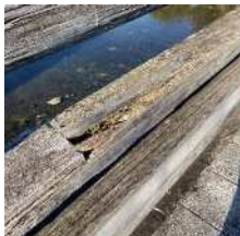
(図1) 腐食している高欄
